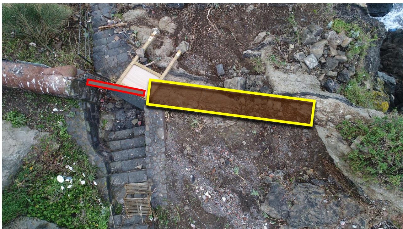
Posizione originaria di muro e pilastro (giallo) e cancello (rosso) – Volo drone
