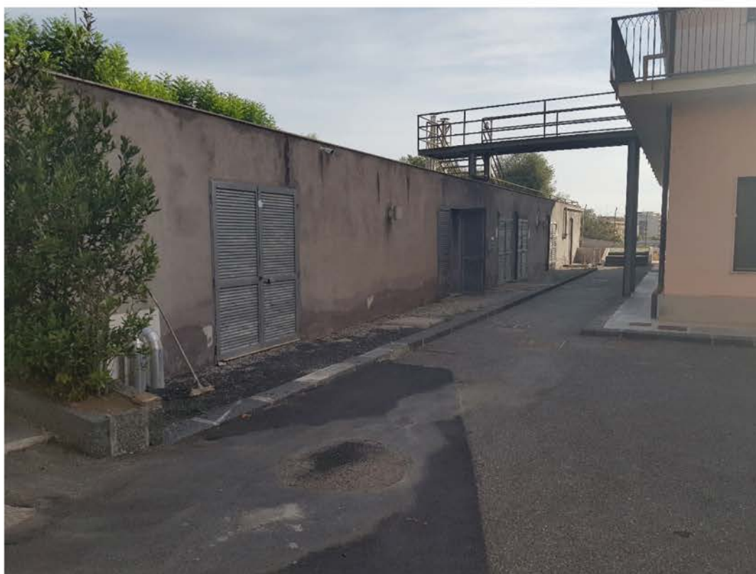
ZONA DI INTERVENTO
