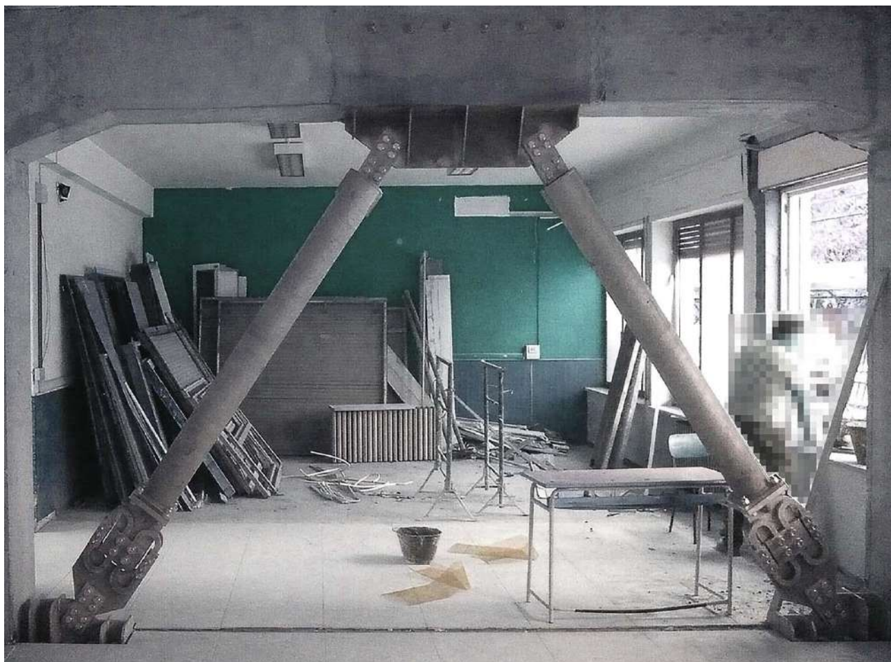
Installazione di controventi dissipativi
